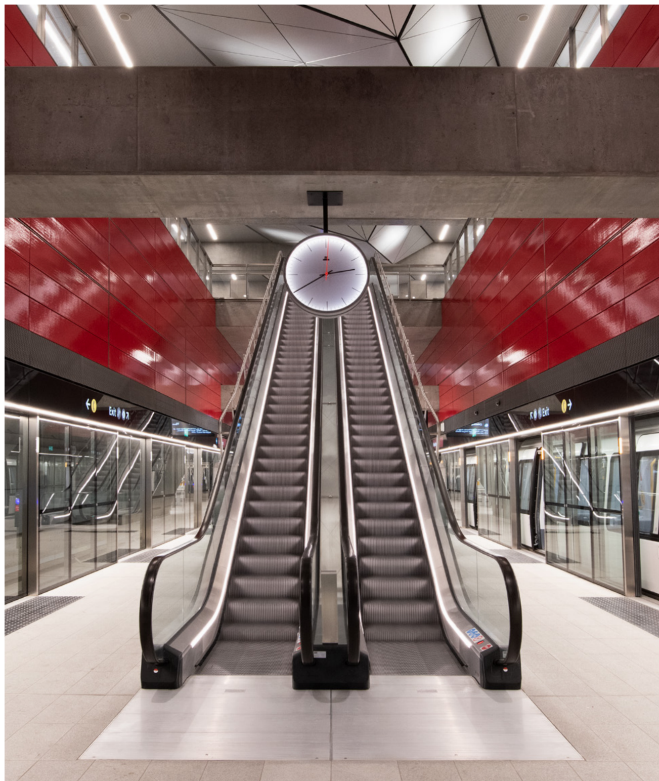
Nordhavn Station – skiftestation til S-tog
